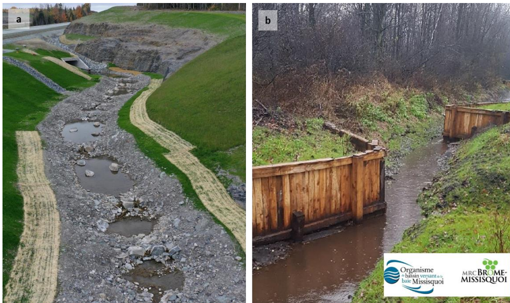
Figure 6. Exemples d'un capital naturel aménagé : a- aménagements fauniques le long de l'autoroute 185 (© Rivières); b- aménagements pour favoriser la décantation des particules fines dans un cours d'eau agricole.
